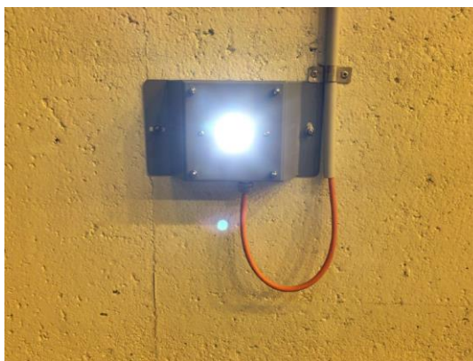
Figura 10: Foto installazioni impianto illuminazione d'emergenza in caso di incendio
